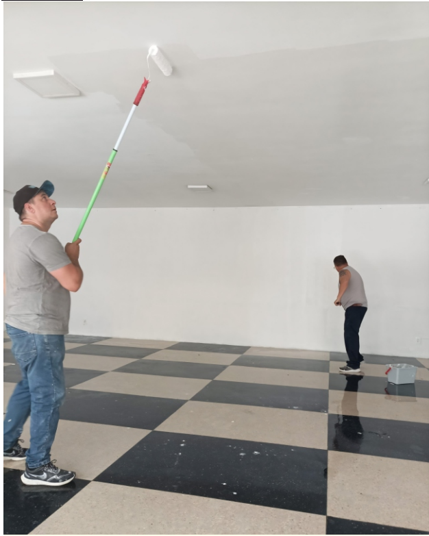
Arreglos y pintura del salón gremial
